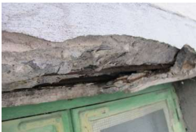
Eksempler på skadeomfang i sokkel
