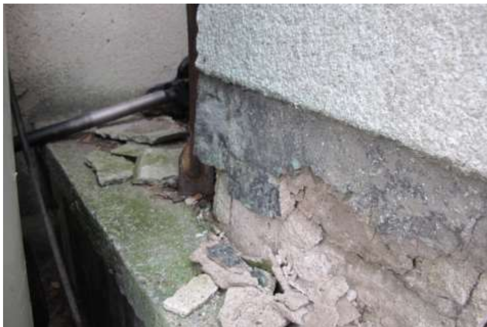
Eksempler på skadeomfang i sokkel
