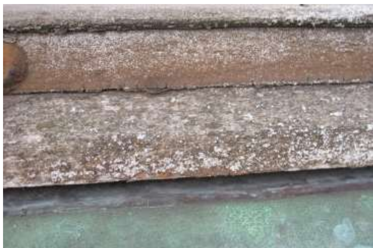
Begrodd, uttørket og slitt vinduskarm. Tekking i kobber med dårlig tilslutning.
