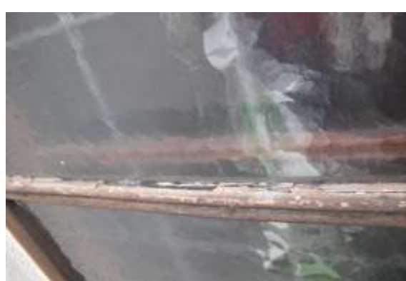
Nødvendig vedlikehold, pussing, kitting, delutskiftning, overflatebehandling.
