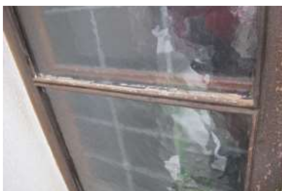
Nødvendig vedlikehold, pussing, kitting, delutskiftning, overflatebehandling.
