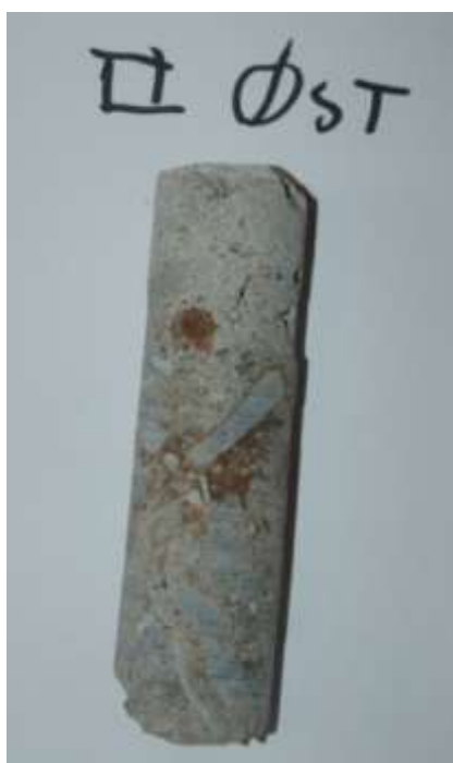
Bilde 9 Kjerne merket Øst 2. Pussen er borte og betongoverdekningen er porøs. Armeringen har vært utsatt for korrosjon.
