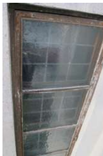
Begrodd, uttørket og slitt vinduskarm. Tekking i kobber med dårlig tilslutning.
