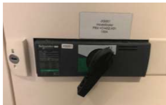
Hovedbryter i en typisk underfordeling
