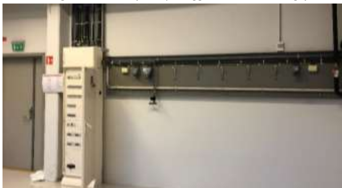
Rom B-10 og B-11: Installasjoner på vegg må demonteres og fjernes.
