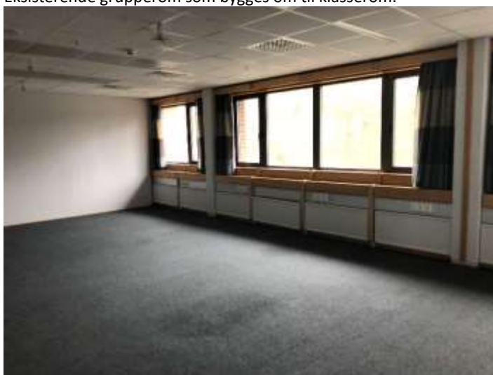
B-23. Eksisterende installasjonskanal og ikke synlig på plantegning.
