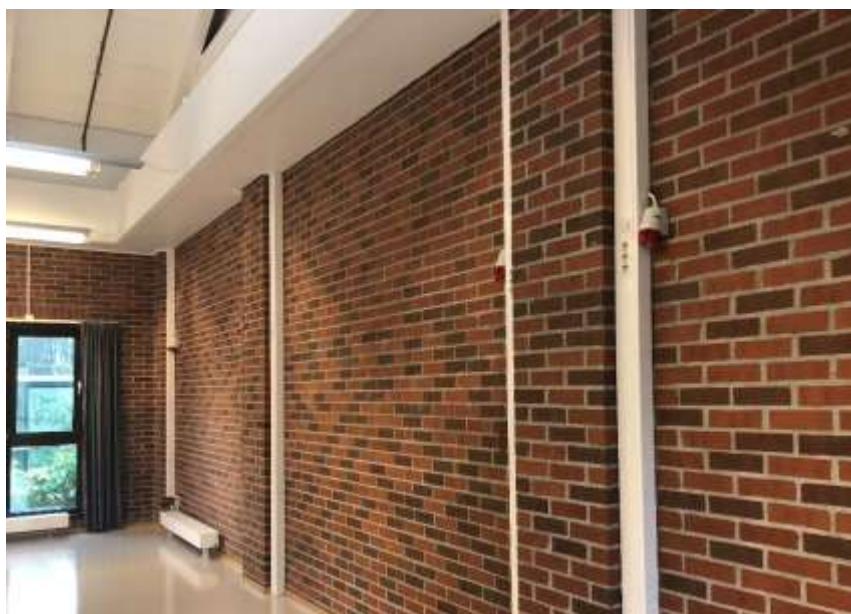
C-115 Bibliotek. Rundstikk demonteres og fjernes
