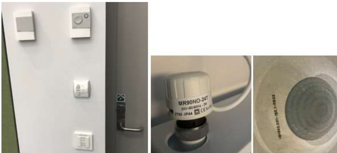
Bilde 01, Romregulering temp, Co2, persienner og Dali lysstyring, aktuator for radiator og pir.
