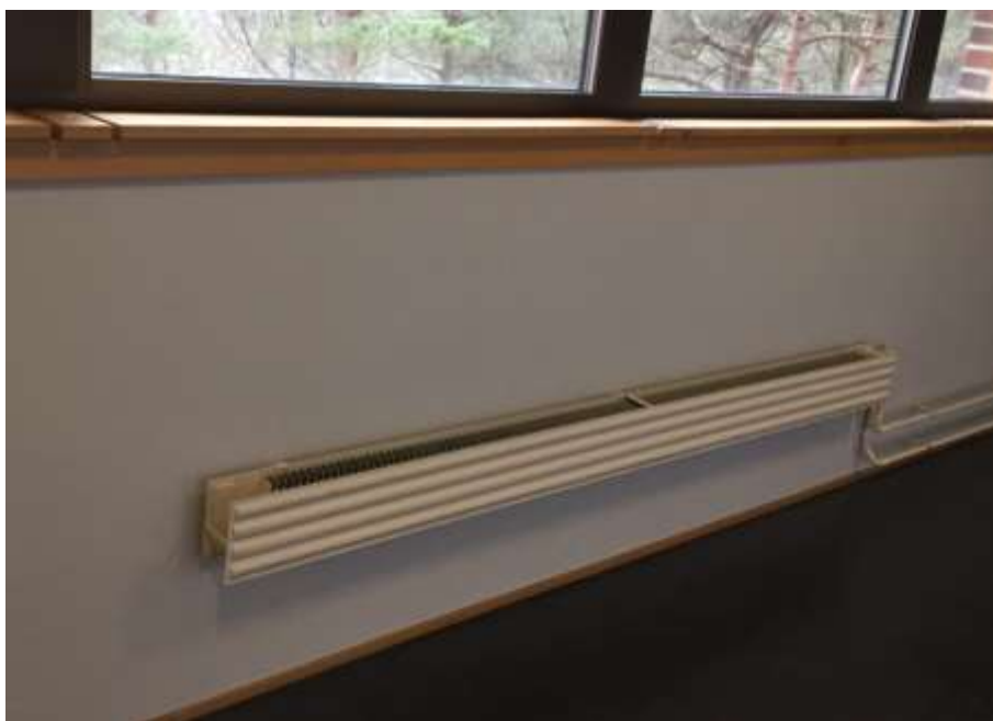
Opprinnelig radiator i korridor 2.etg. Bygg B.
