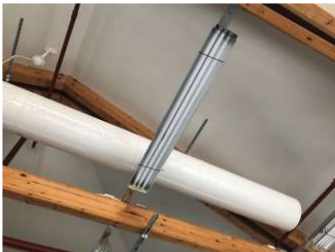
Rom B-12 og B-13: Eksisterende belysning demonteres
