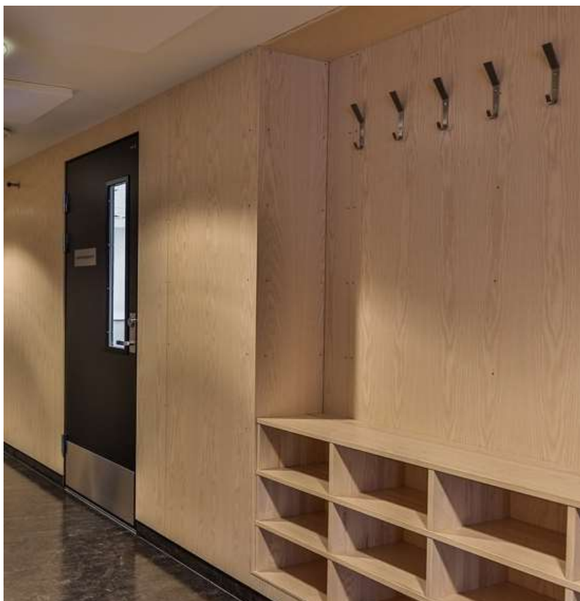
Eksempelbildet viser kryssfinerplater som kledning på vegg.
