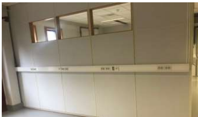
Rom B-10: Vegg rives og installasjonskanaler må demonteres og fjernes
