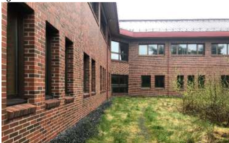
Uteareal for barnehage. Armatur monteres på fasade for områdebelysning av lekearealet.
