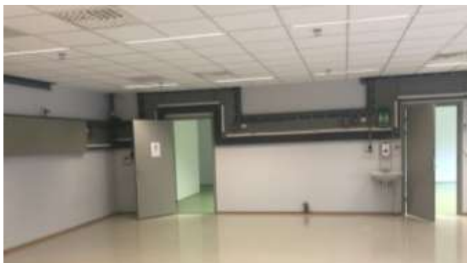
Rom B-10 og B-11: Installasjoner på vegg må demonteres og fjernes.
