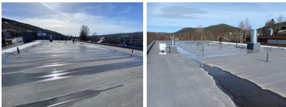
Figur 2: Taket til SFO bygget sett fra nord (venstre) og fra sør (høyre).
