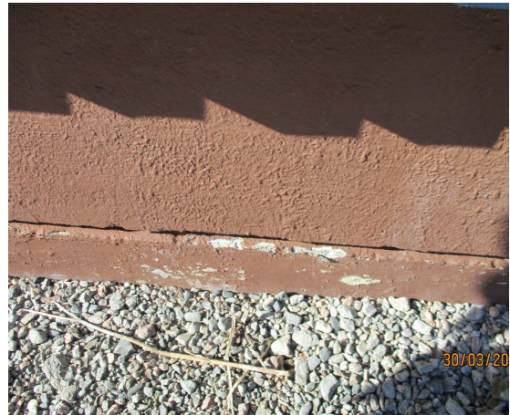
Figur 9 Malt grunnmur utvendig.
