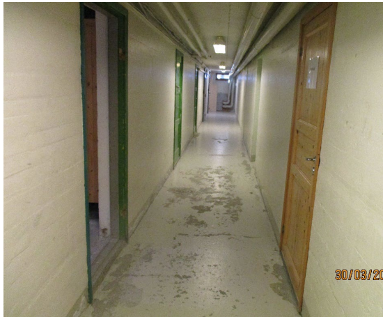
Figur 8 Betonggulv og vegger i kjeller.
