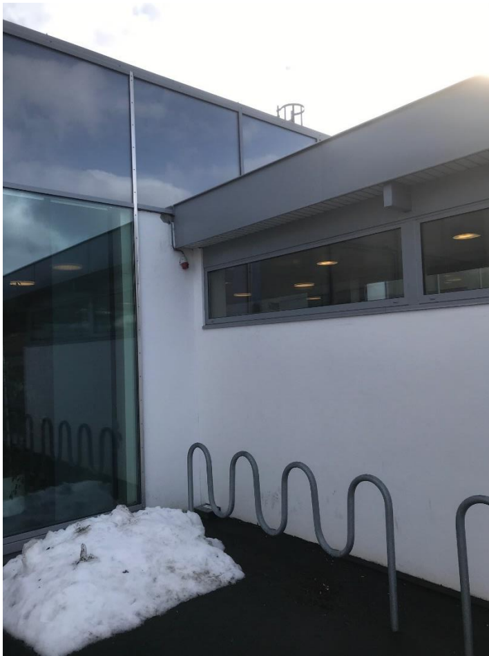
Figur 18: Bilde viser overgang fra hovedtak til tak svalgang.
