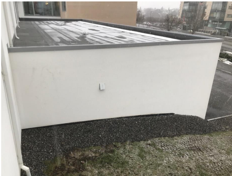
Figur 17: Bilde viser vegg på kaldlager hvor det ønskes leder.
