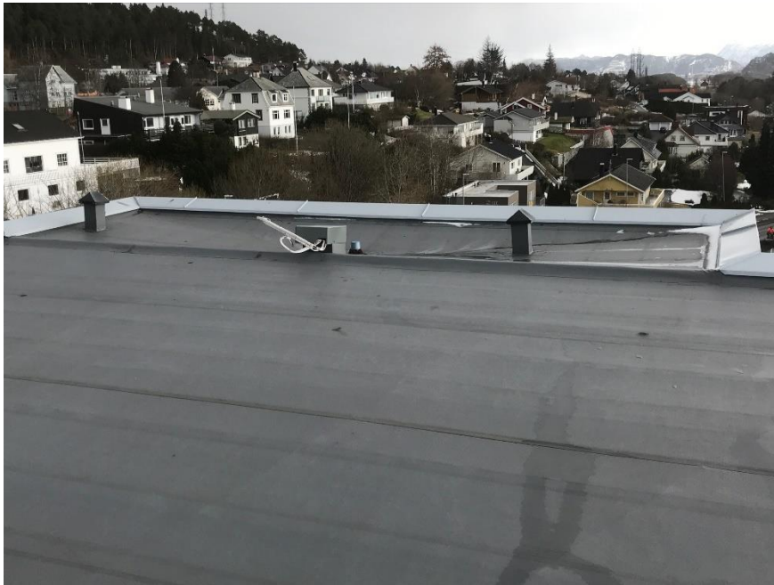
Figur 2: Bilde viser sluk på øst side av G-bygg, sluk i senter.
