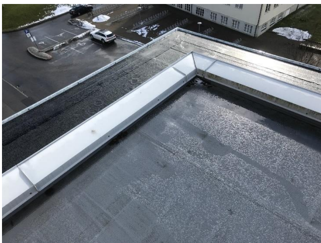
Figur 10: Bilde viser tak utenfor gesims på SØ- hjørne av C-blokk.
