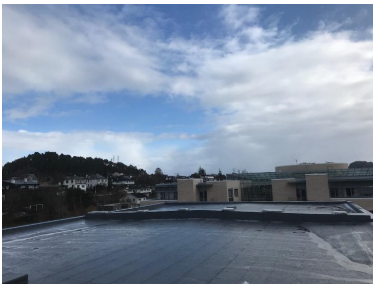
Figur 5: Bilde viser tak over gymsal.
