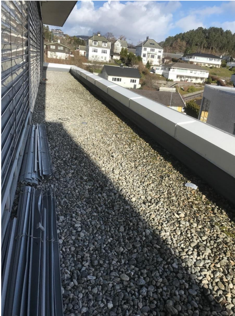
Figur 12: Bilde viser tak på øst side over 3. etasje C-blokk.
