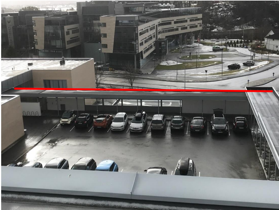
Figur 19: Bilde viser svalgang sett ovenfra. Blå linje angir område som trenger sikringsløsning.
