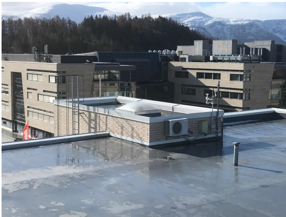
Figur 14: Bilde viser trappehus på nord side av F-blokk.
