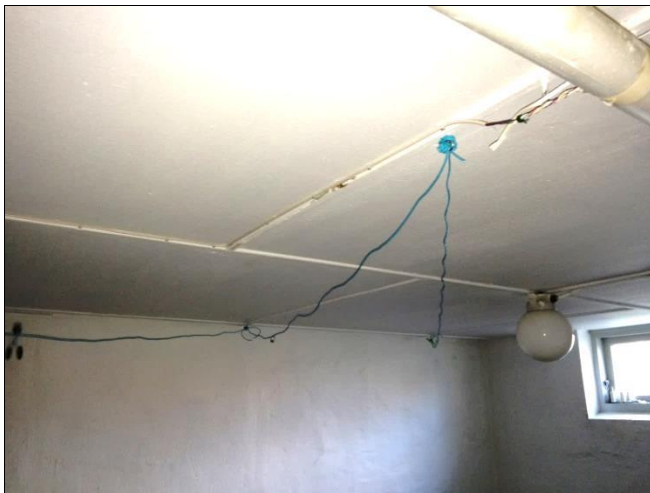
Figur 2: Platekledning i vaskerommet i Tingvollen 5C, eternitplater med asbestinnhold.
