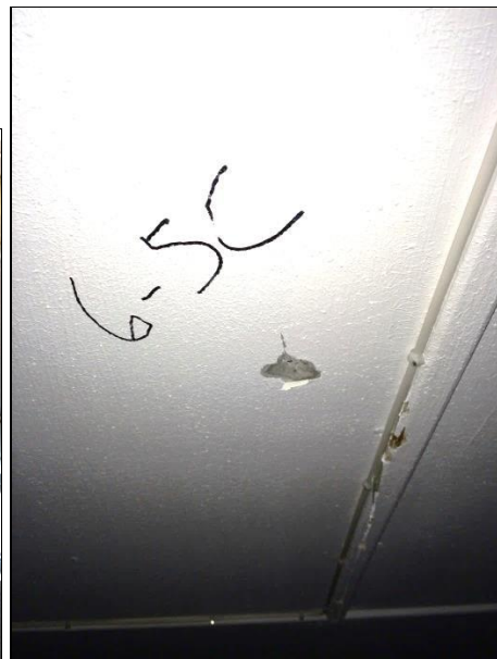
Figur 2: Platekledning i vaskerommet i Tingvollen 5C, eternitplater med asbestinnhold.
