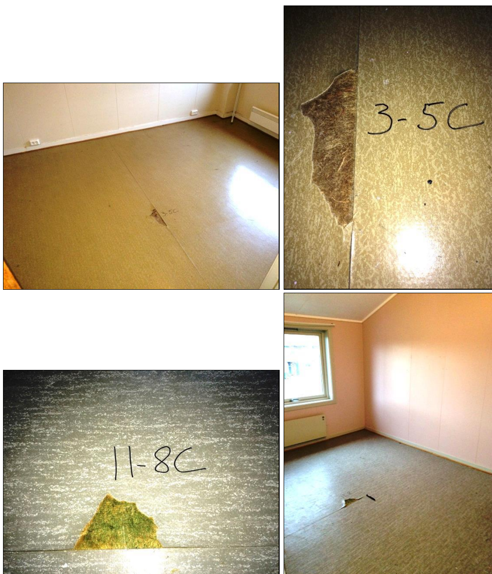
Figur 11: Vinyl gulvbelegg som ble analysert for innhold av ftalater og klorparafiner.
