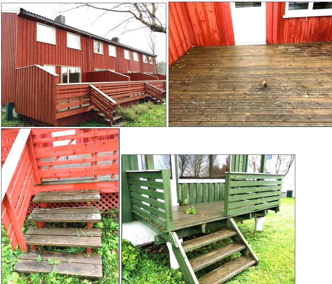
Figur 14: Terrasser og balkonger er bygget med trykkimpregnert trevirke (CCA-impregnert).
