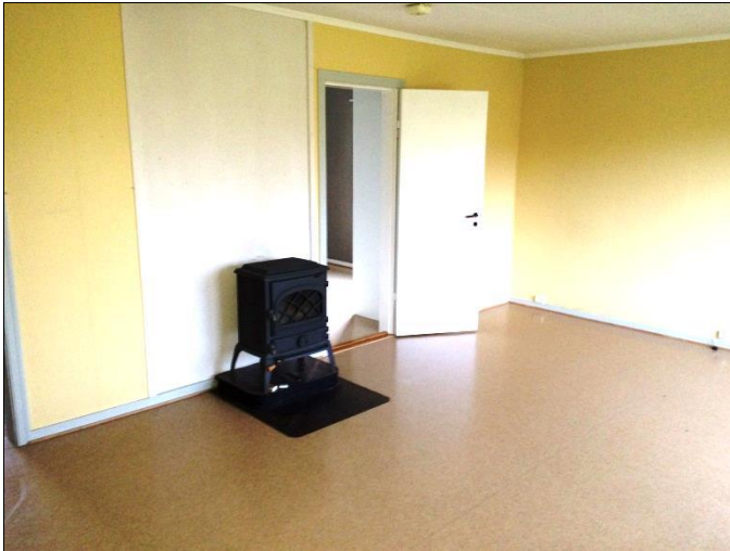
Figur 15: Typisk vedovn som ble registrert i leilighetene. Pipeløpene er forurenset med PAH.
