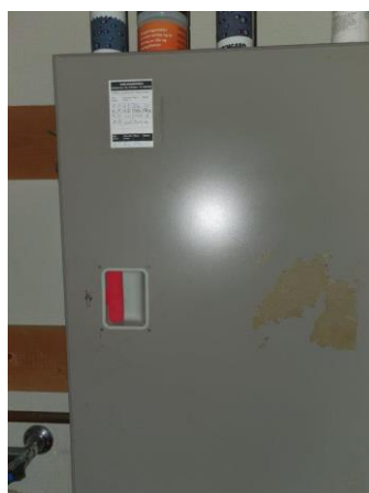
Bilde: Brannskap i bod
