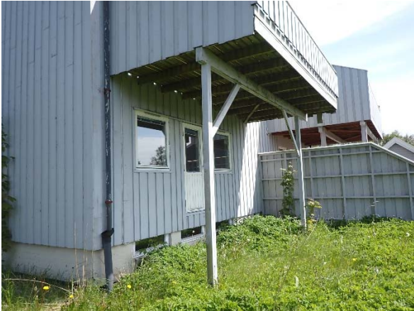
Figur 5 11A Fasade mot nordvest.
