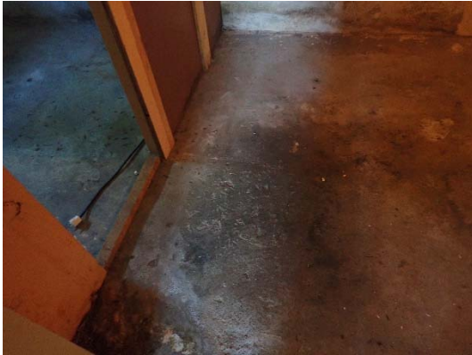
Figur 16 Betonggulv i kjeller i 11A (117-1)
