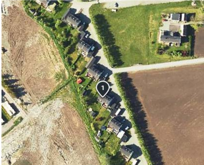
Figur 2 Flyfoto som viser bygningsmassen i Meldalsveien 11A og 11B. Kilde: gulesider.no
