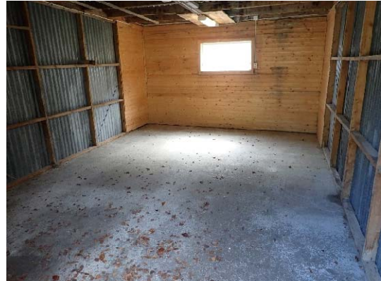
Figur 17 Betonggulv i garasje 11B (118-1).
