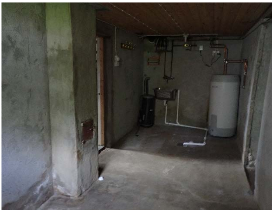
Figur 18 Betonggulv og – vegger i kjeller 11B (118-2).
