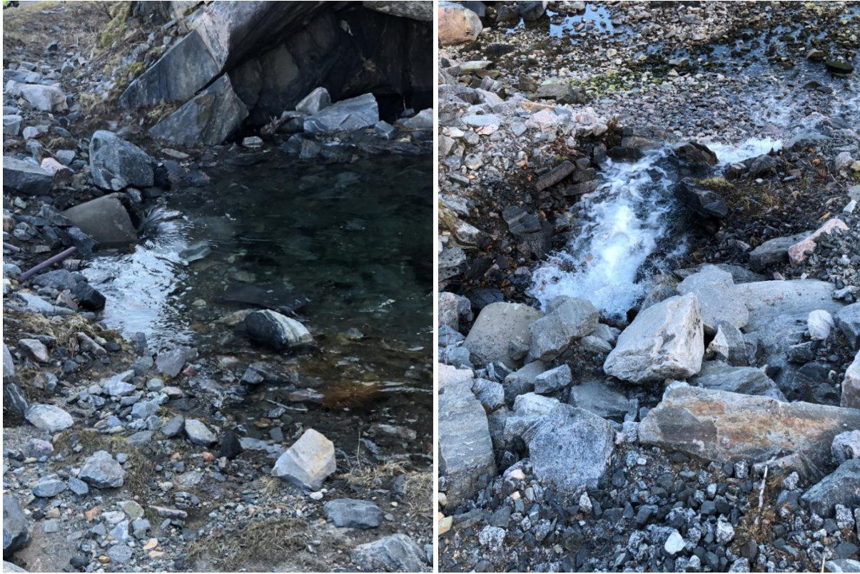
Figur 1.5 Innløp (t.v.) og utløp (t.h.) for eksisterende \varnothing 600 mm stikkrenne
