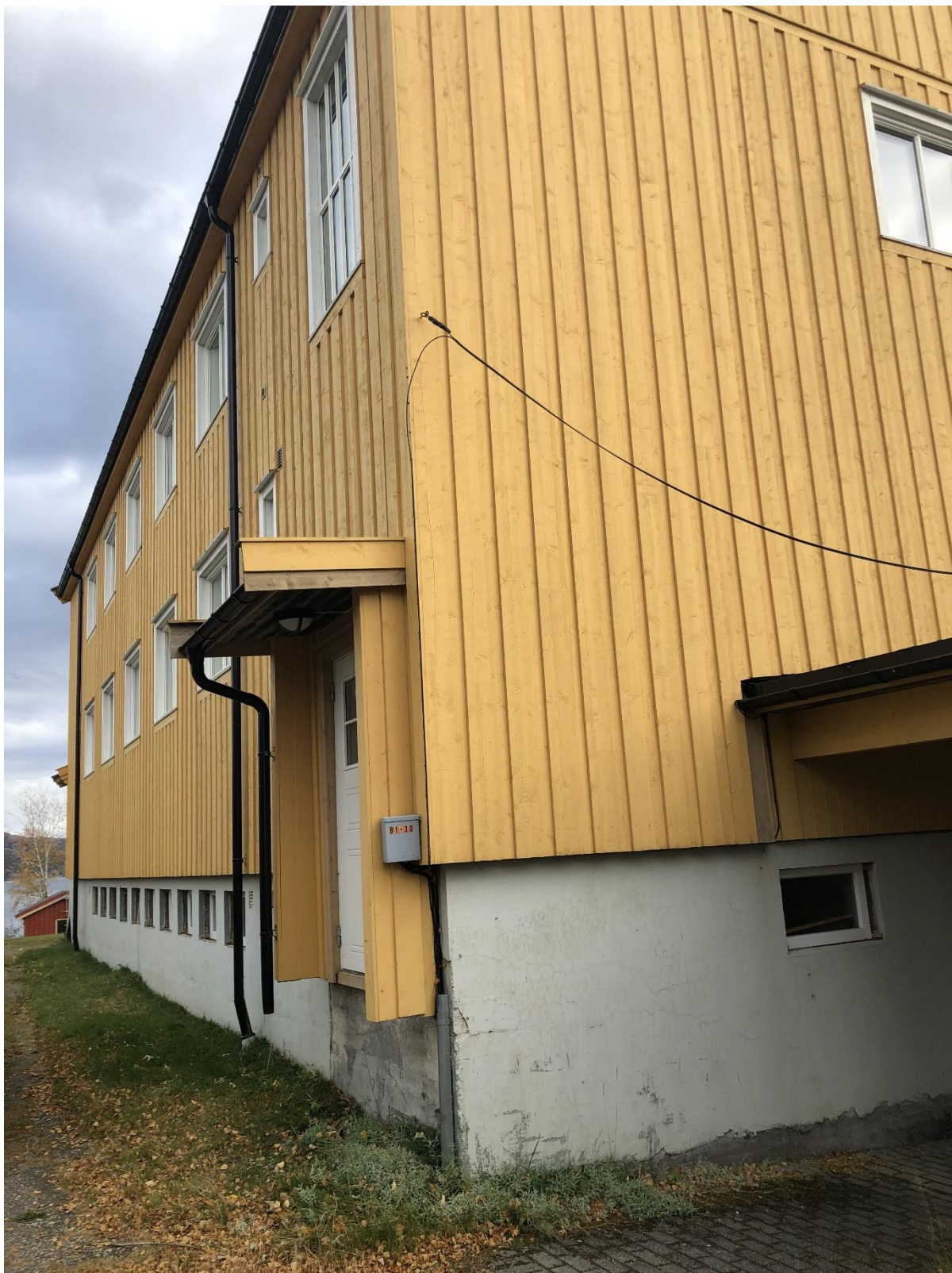
Langvegg mot nordvest. Her etableres en ny rømningsvei med rampe.
