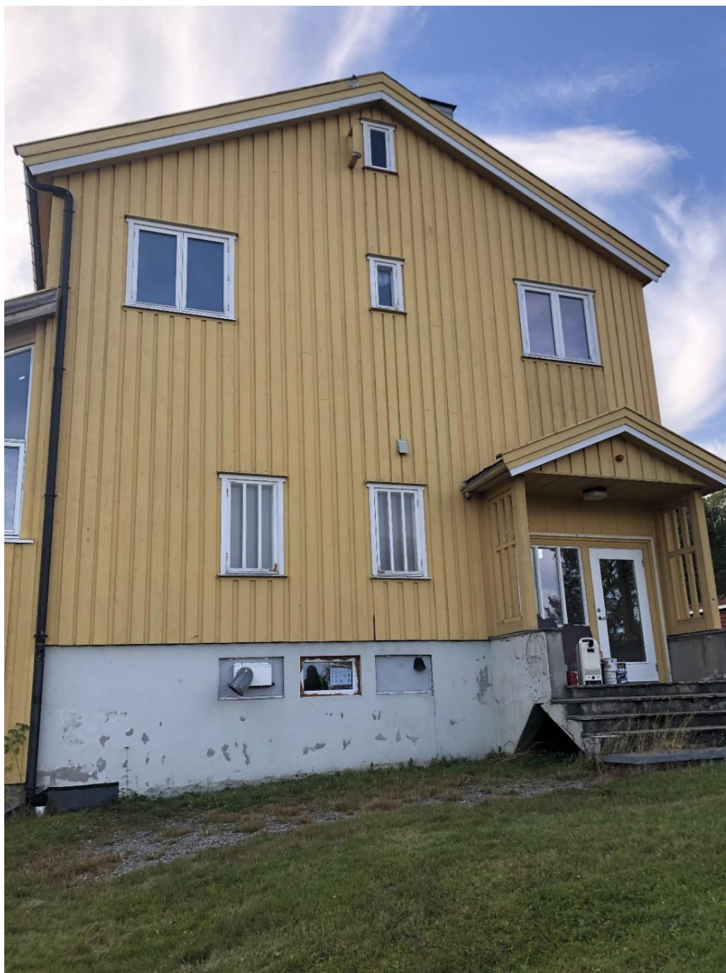
Fasade mot nordøst. Her fjernes noen vindu og det etableres en utgang (balkongdør) og trapp til terreng.
