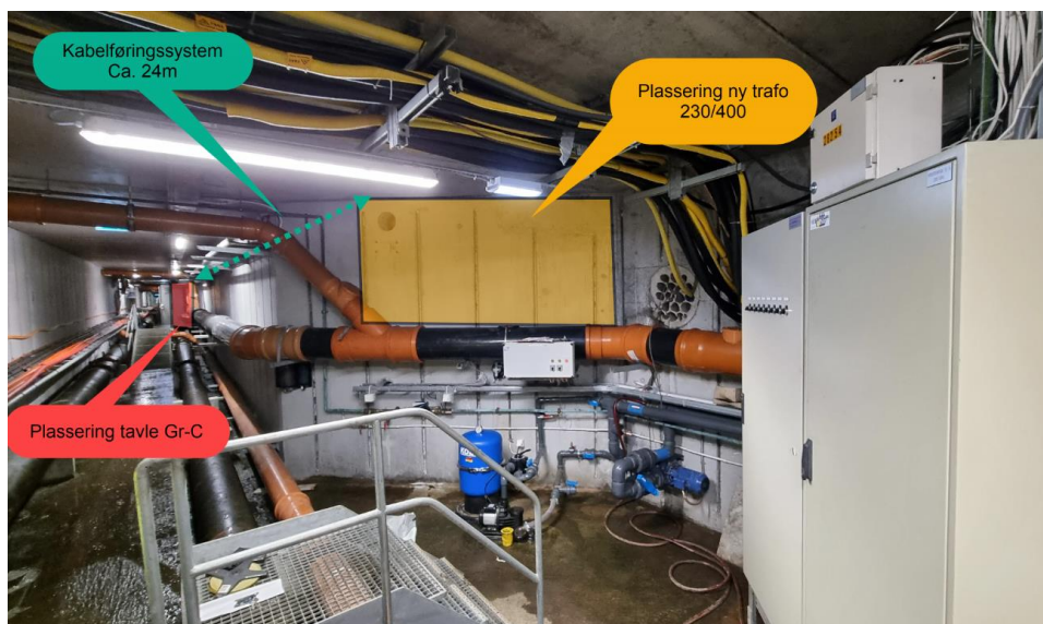
Bilde 7.4.1: Plassering av ny Trafo i Kulvert
