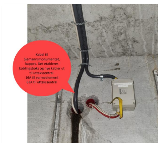
Bilde 7.6.3 Kulvert, Torgallmenningen
