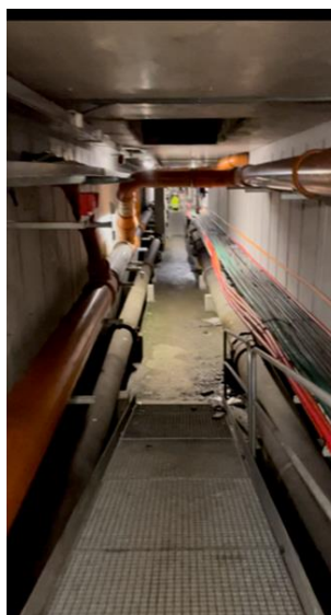
Bilde 7.9.2 Tilkomstsluke, sett fra kulvert.
