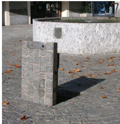
Bilde 7.6.5 Eksempel Undergrunnsfordeler
