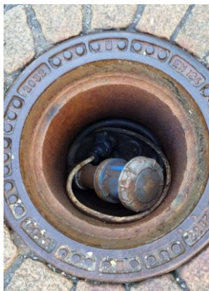
Bilde 7.6.1 Eksisterende strømuttak ved Sjømannsmonument
