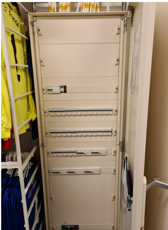
Fordelingstavle for forbrukskurser. Her kan det avsettes til nye kurser for utelys og boder.
