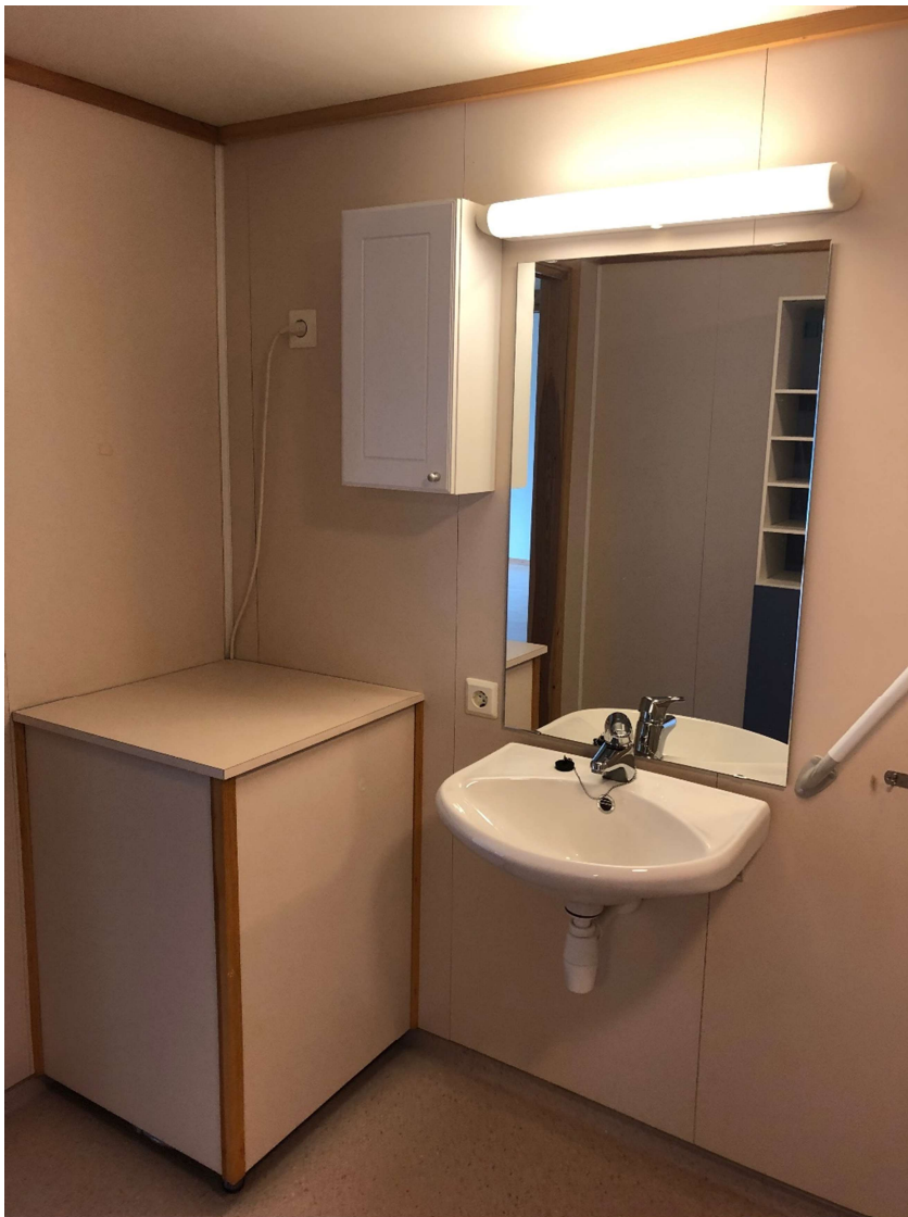
Veggskap, speil og lys over speil skal fjernes
