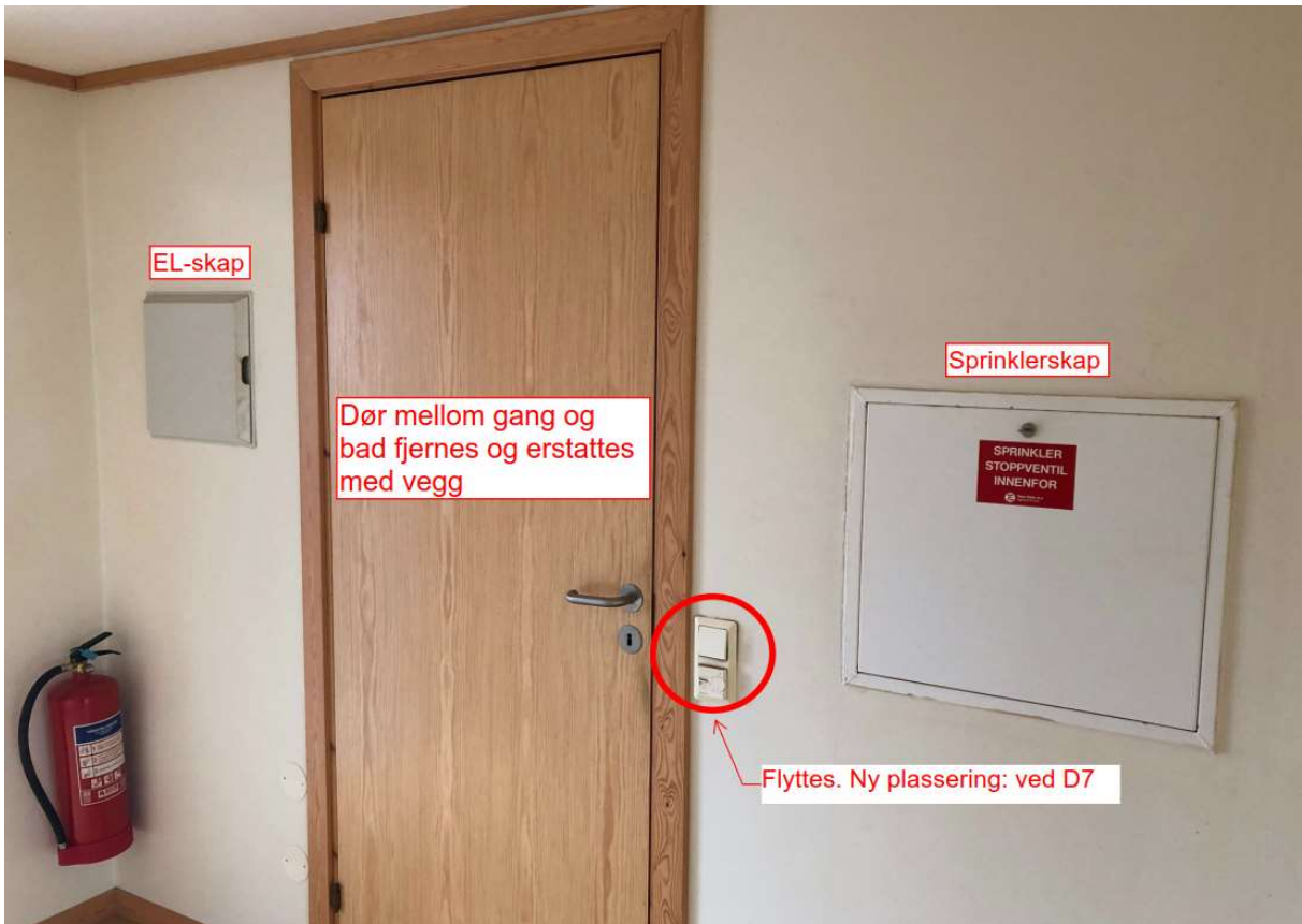
Eksisterende situasjon ved vegg mellom baderom og gang begge leiligheter.
