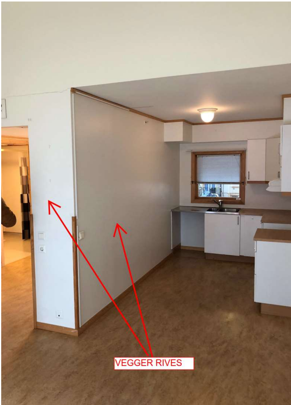
Vegg mellom kjøkken og gang i leilighet nr. 24/HO301 fjernes. EL-anlegg omlegges
