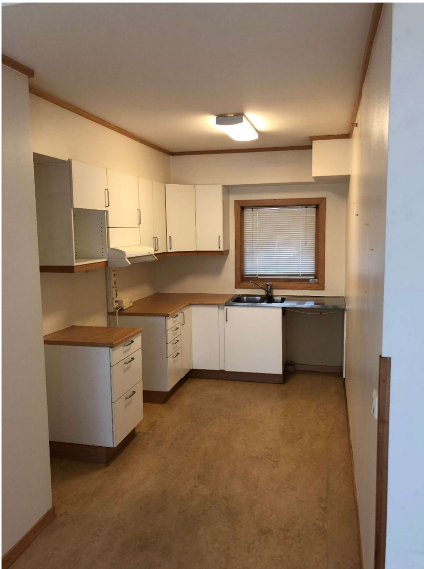
Kjøkkeninnredning som skal fjernes
