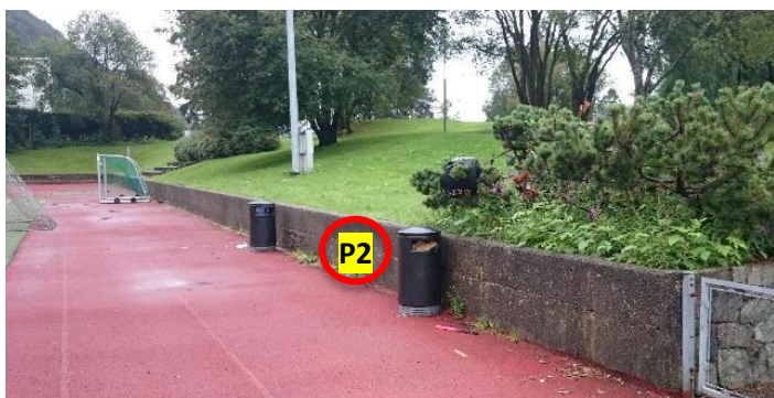
Figur 10 Prøveplassering for P2, betongmuren langs vestre banekant.
