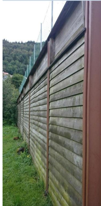
Figur 5 Bildet viser gjerdet av tre og metallstolper, som ligger i nordenden av banen. Trevirket i gjerdet skal demonteres og leveres til godkjent mottak. Foto er tatt mot øst.
