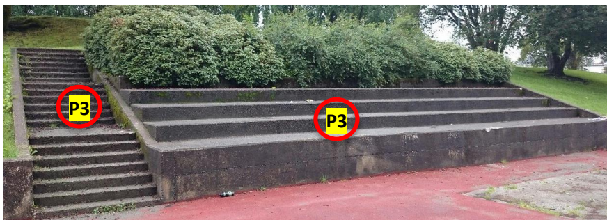
Figur 11 Prøveplassering for P3, blandeprøve av betongtrapp og tribune ved vestre banekant.
